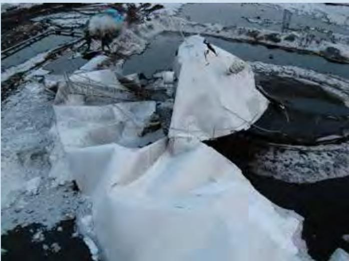
**Рис. 2. Разрушенный резервуар РВС-700 № 49**
